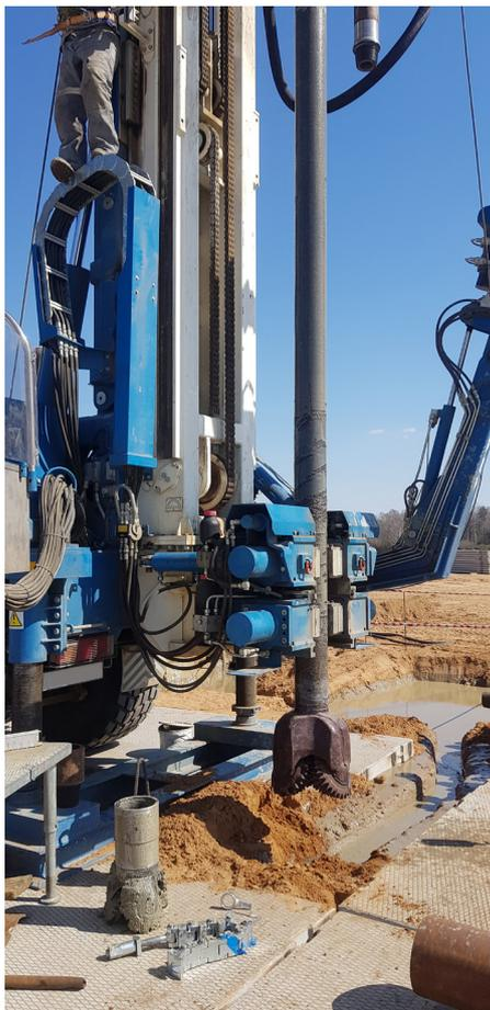
Zur Anlage von Sanierungsbrunnen sind entsprechende Vertikalbohrungen notwendig
