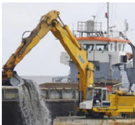
Baggerarbeiten am Jade-Weser-Port
